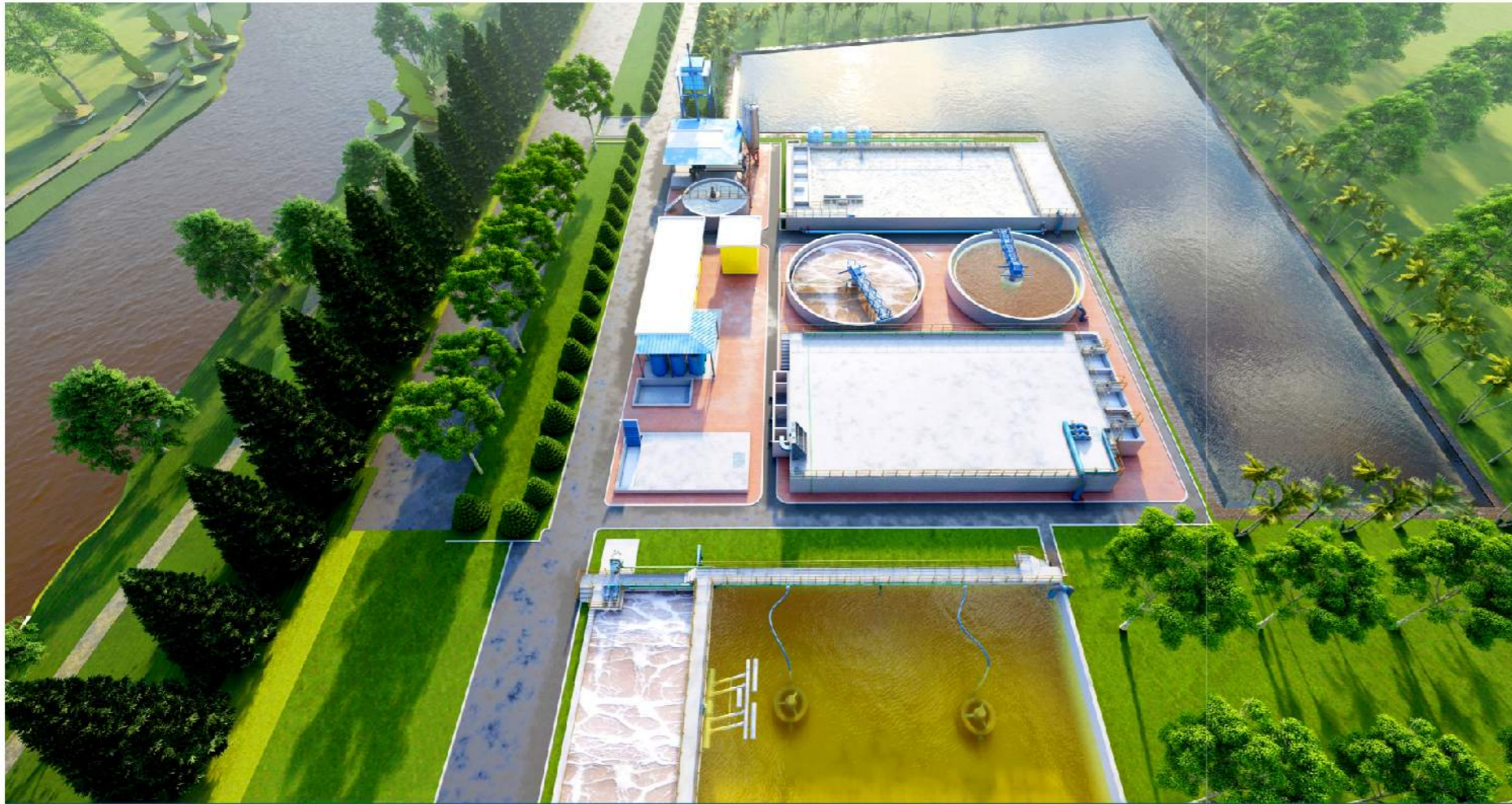
NHÀ MÁY XỬ LÝ NƯỚC THẢI MỸ PHƯỚC 3 GIA ĐOẠN 2 MY PHUOC 3RD WASTEWATER TREATMENT PLANT, PHASE 2
